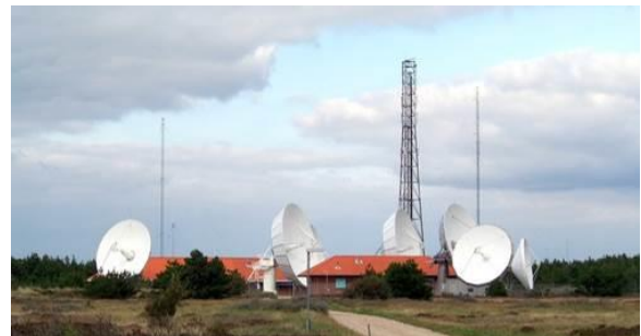
Blåvand Radio og antenneanlæg, syd for lokalplanområdet.
